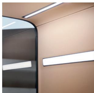
Die stilvolle Innenverkleidung aus schallabsorbierendem PET-Material lässt sich leicht reinigen und bei Bedarf austauschen.
